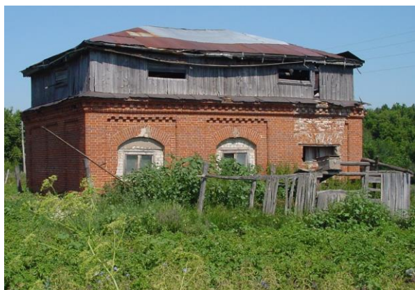
Усадьба О.С. Боянус. Село Свободные Ключи – Най-Лебен. Хозяйственные постройки. Фото С.А. Осьмачкиной. 2001 г.
