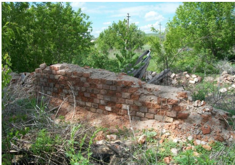
Развалины больницы, построенной из церковного кирпича. Село Березняки
